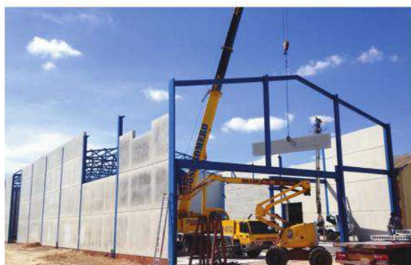
Naves Totalmente Terminadas
