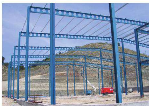
Estructuras de Grandes Vanos
