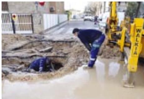
Seguramente el que no se ha metido en una zanja, con el agua hasta las rodillas y utilizado una radial de gran tamaño para cortar viejos tubos de hierro, oxidados, rotos, agredidos por recias raíces, con la cercana presencia de cables de electricidad, podrá pensar que eso no es tan difícil. Bien, sus razones tendrán. Pero desde aquí dejamos constancia de su trabajo nada cómodo para
